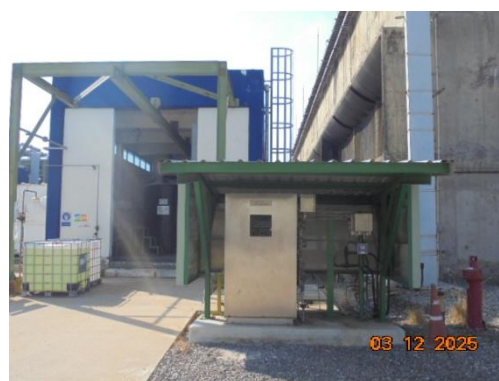
ภาพที่ 3-54 Conductivity Online ที่ Cooling Blowdown
