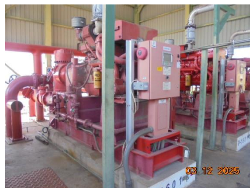
ภาพที่ 3-48 แหล่งน้ำสำรองดับเพลิง และเครื่องสูบน้ำดับเพลิง
