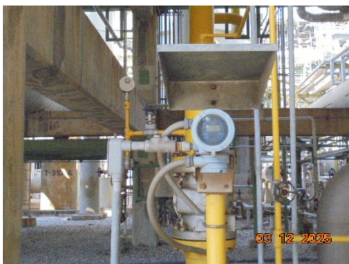
ภาพที่ 3-41 Flammable Gas Detector
