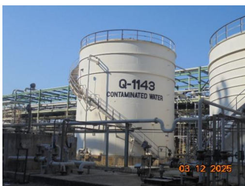
ภาพที่ 3-7 Contaminated Water Surge Tank (Q-1143)
