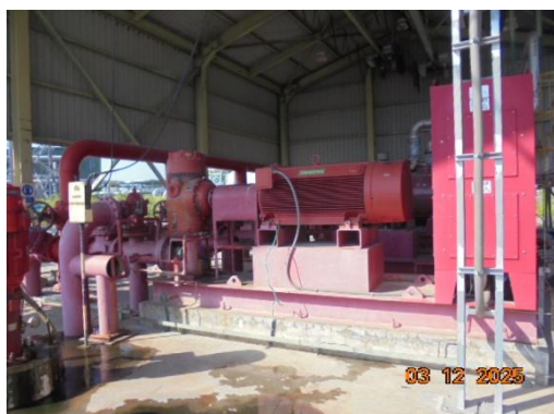
ภาพที่ 3-48 แหล่งน้ำสำรองดับเพลิง และเครื่องสูบน้ำดับเพลิง
