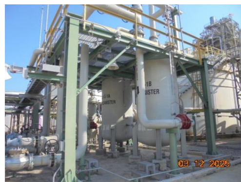
ภาพที่ 3-52 ระบบ Activated Carbon Canister
