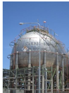
ภาพที่ 3-50 ถังเก็บกักสาร 1,3-บิวทาไดอิน บริเวณท่าเทียบเรือ และคลังผลิตภัณฑ์
