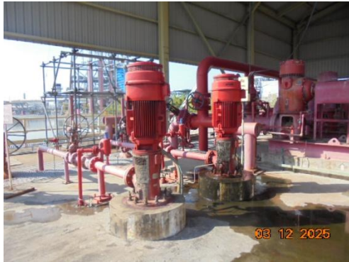
ภาพที่ 3-48 แหล่งน้ำสำรองดับเพลิง และเครื่องสูบน้ำดับเพลิง (ต่อ)
