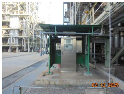
ภาพที่ 3-5 อุปกรณ์ตรวจวัดมลพิษอัตโนมัติแบบต่อเนื่อง (CEMS)
